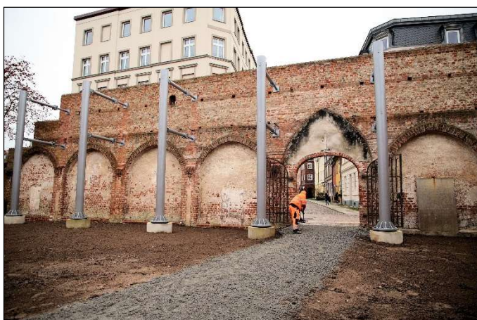
Stabilisierte Außenwand des Johannisklosters
