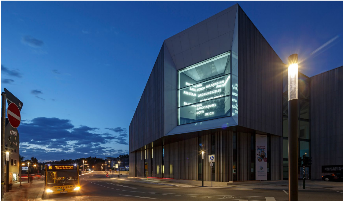
Das Haus der Bayerischen Geschichte wird vollständig mit Wärme und Kälte aus Abwasser klimatisiert.
