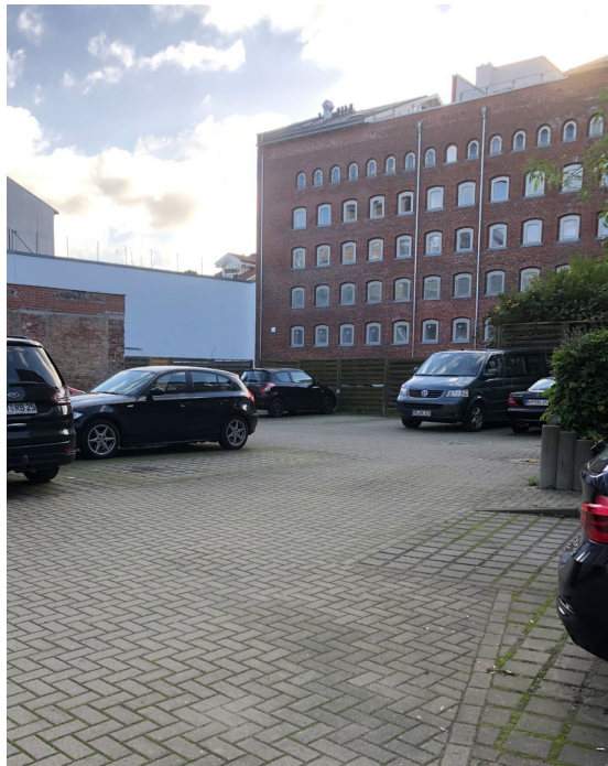
Rechts: Ein Innenhof im Quartier 25 wurde für das Anwohnerparken voll versiegelt.
