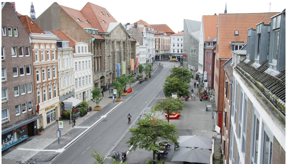
Planungsversuch in der Beckergrube in 2020 (Straßenrückbau und temporäre Möblierung/ Bespielung)
